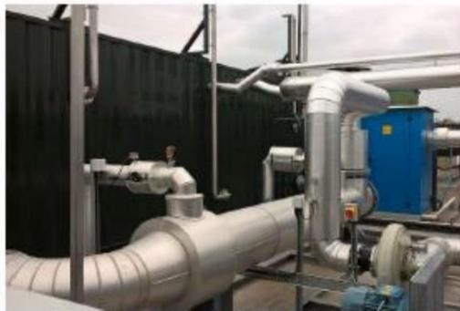
*Refroidissement biogaz et déshumidification*
