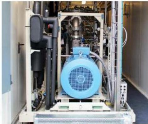
Compresseur à vis pour biogaz
